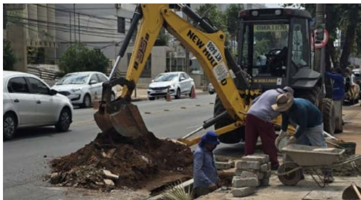
Limpeza removeu 15,4 toneladas de resíduos: manutenção incluiu a limpeza de 166 bocas de lobo e 150 metros de ramais
