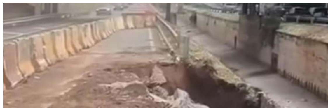
Intervenção ocorre no trecho entre a ponte da Rua 21 e a Rua 10
