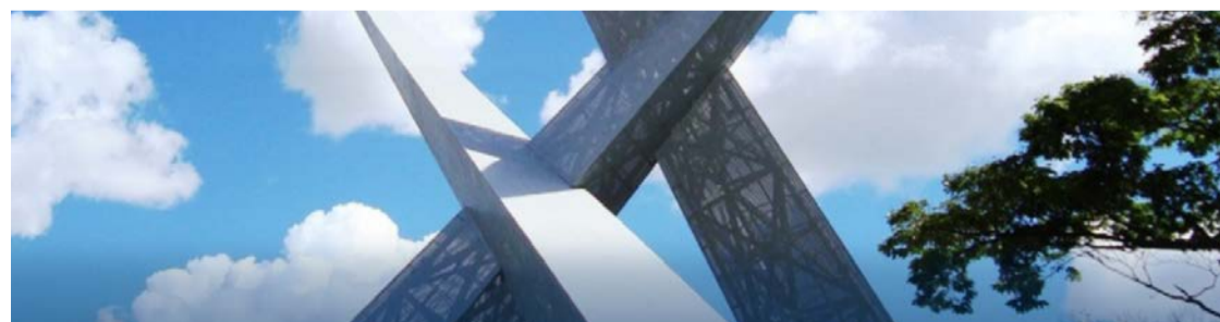
Prefeito de Goiânia, Sandro Mabel, dá início à intervenções em viadutos da 85
