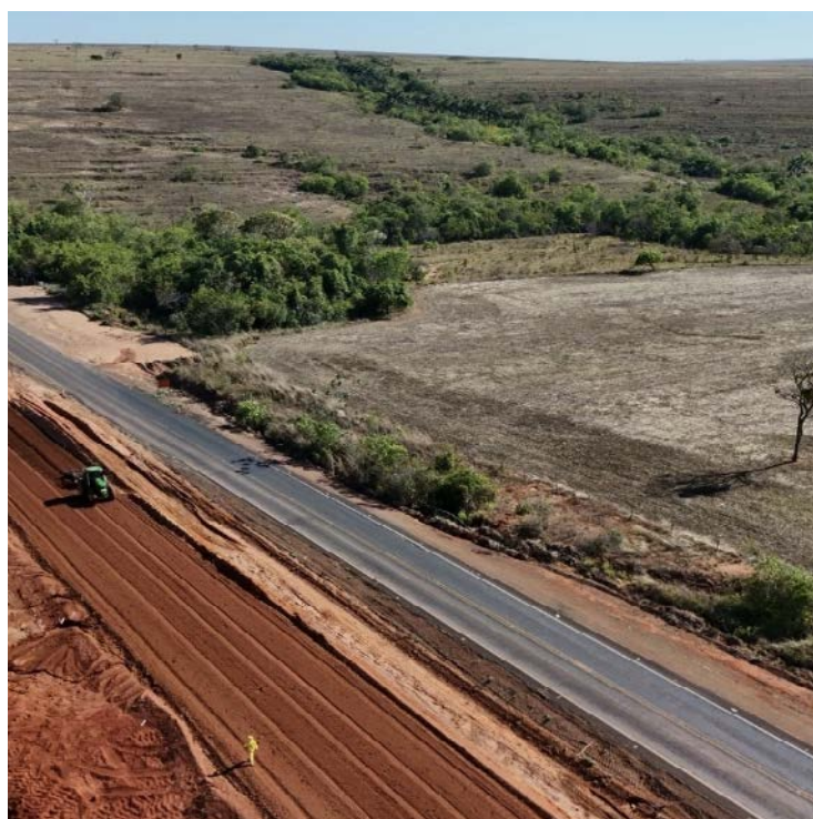
Obras nas GOs 139, 213 e 309 ampliam acesso na região das Águas Quentes
